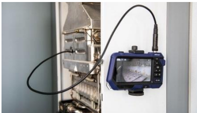
Abb. 6: Endoskop an Wand befestigt
